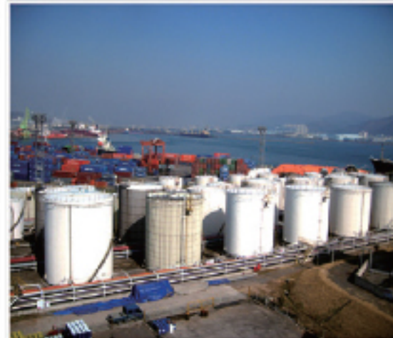
STORAGE TANK 및 예송설비
