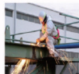
공장철골 철거 및 신설
